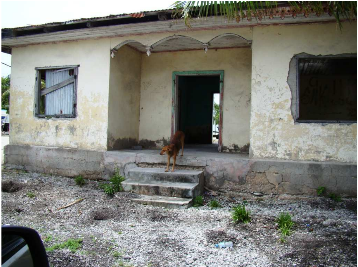
Figure 21 : Maison à Avatoru avec une dalle de 0,5 m approximative (Worliczek 2009)
