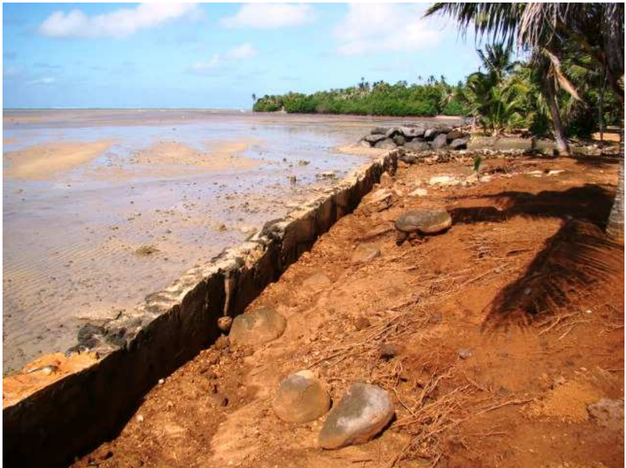
Figure 42 : Un mur de protection qui n'est plus efficace à la cote est de Wallis (Worliczek 2009)
