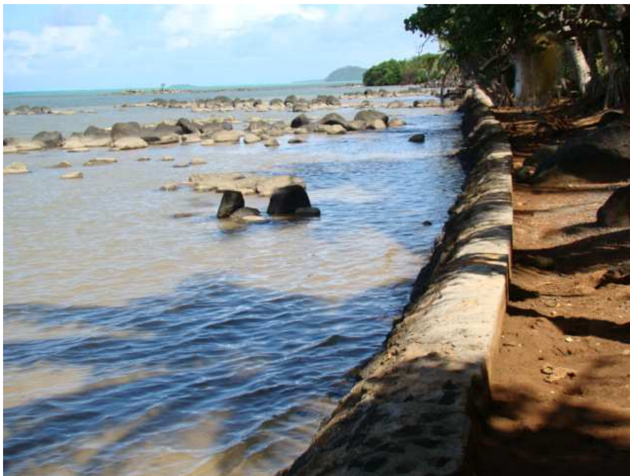
Figure 43 : Le 'utu à Alele (alignement de roches perpendiculaires au mur de protection littoral) (Worliczek 2010)
